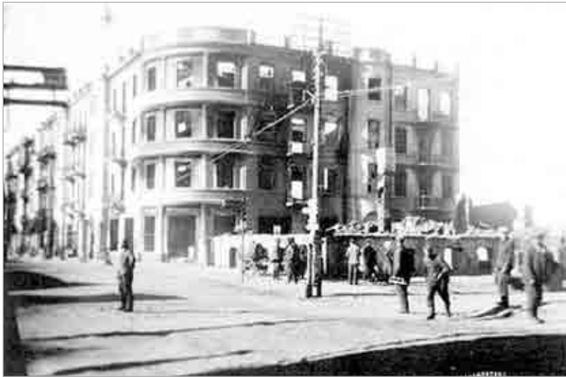
Житловий будинок ОВК-3 на вулиці Шевченка (навпроти головноштамту). Не зберігся.
